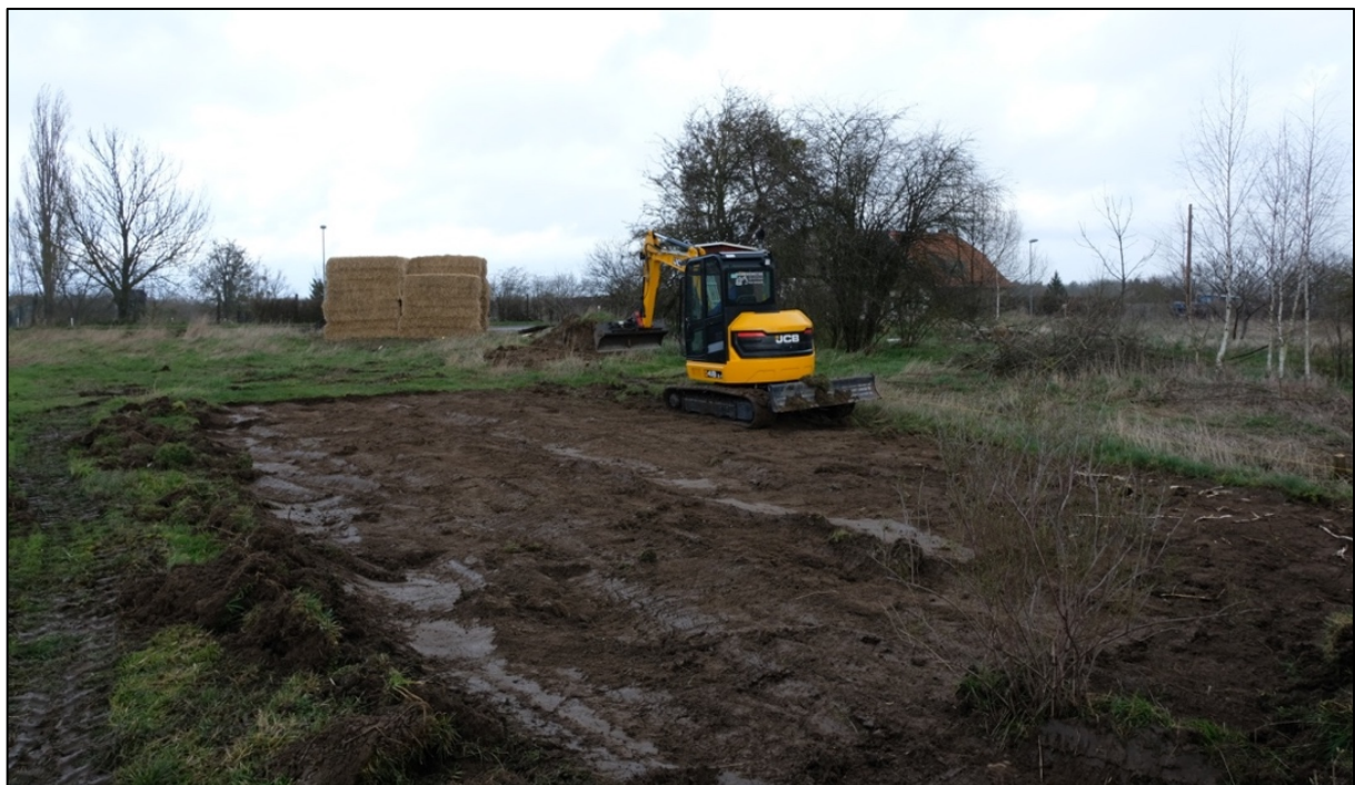
Abbildung 16 – Abziehen der Grassnarbe (Eigene Darstellung)
