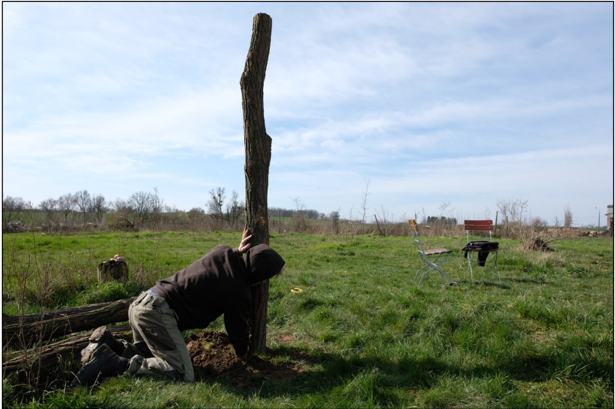
Abbildung 19 - Robinienpfähle werden versenkt (Eigene Darstellung)
