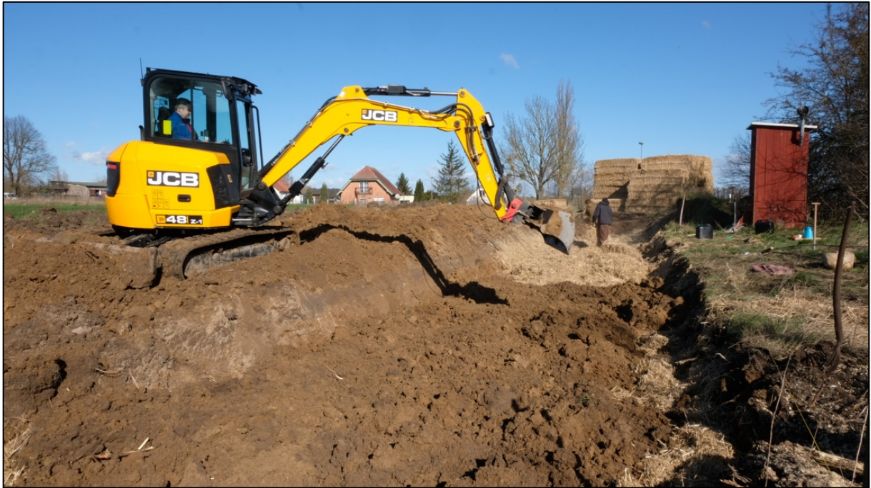
Abbildung 17 – Streifenweiser Aushub (Eigene Darstellung)
