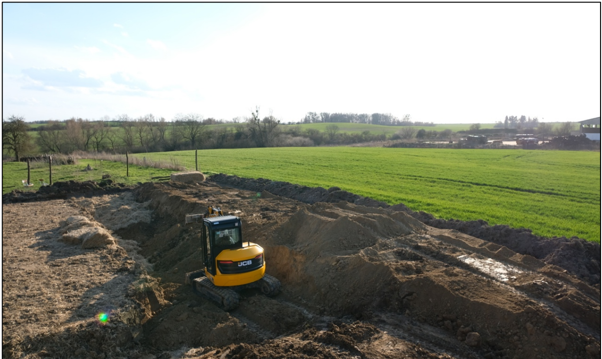
Abbildung 18 - Wiedereinbringung des Aushubs (Eigene Darstellung)
